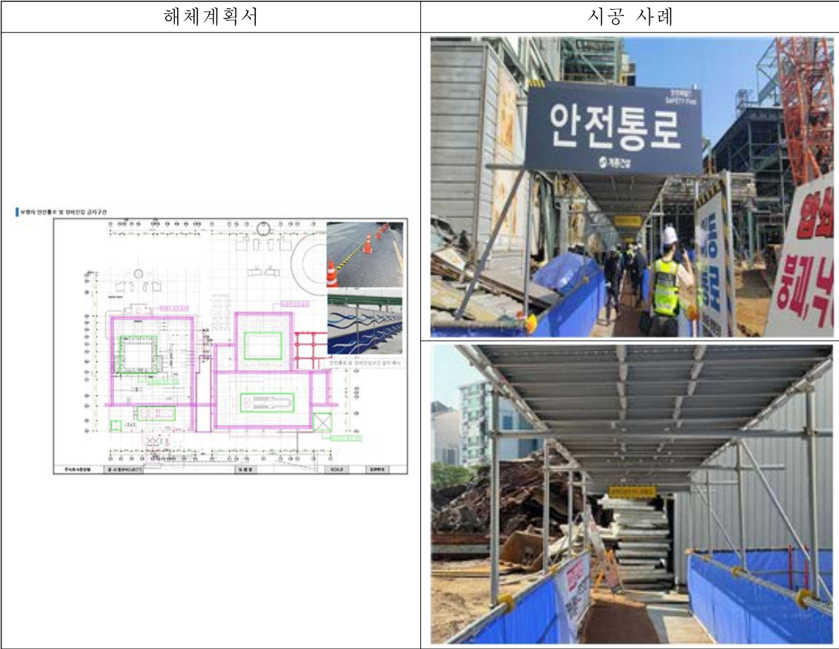
<그림 12-7> 해체현장내 작업자 안전통로 설치계획 및 시공 사례
