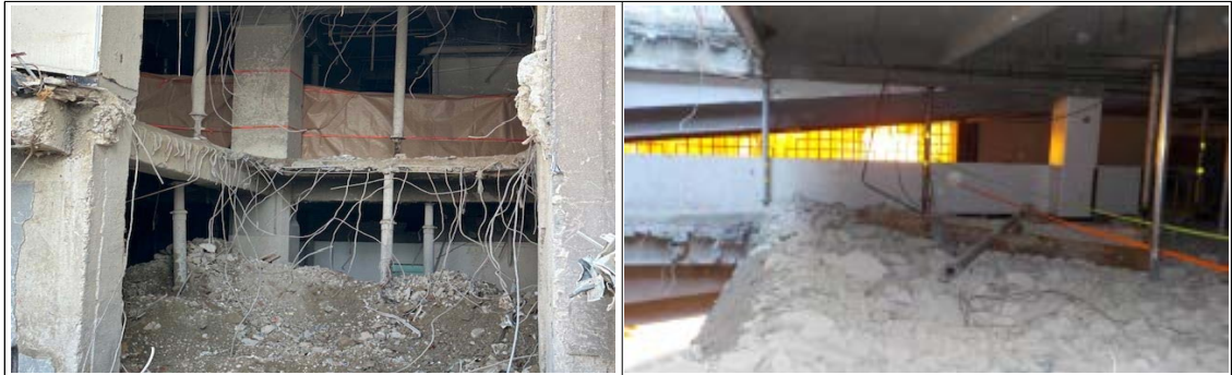
<그림 11-1> 잔재물로 인한 잭서포트의 기울, 전도 등
